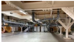
給排水衛生設備 [配管及び器具設置]
