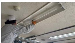
蛍光灯取付作業
