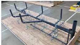
屋内給排水設備 [配管施工]
