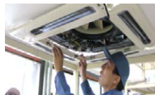
業務用エアコン メンテナンス作業
