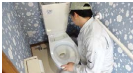
建築設備(衛生器具)の施工実習
