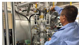
ボイラー操作
