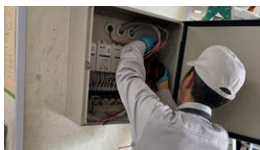
制御盤の配線作業
