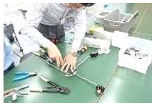
電気工事作業
