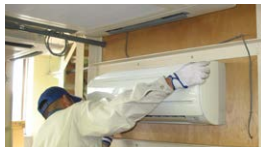
エアコン取付作業
