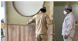
技能祭店舗設計・施工実習
