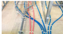
建築設備(配管)の施工実習
