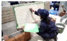
外構実習 仕上げ作業の様子
