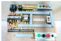
電気制御回路組立実習
