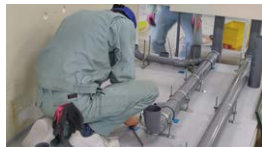
排水配管作業
