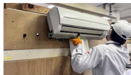
エアコンの取り付け作業
