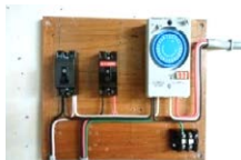
電気工事実習(分電盤)
