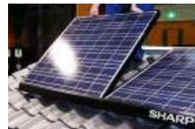
電気設備施工実習
