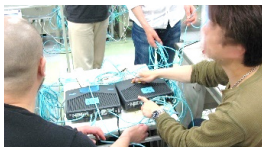
ルータの配線準備
