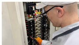
メガーによる絶縁抵抗測定作業
