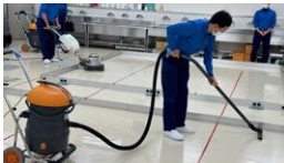
実習風景 (給水パキュム作業)
