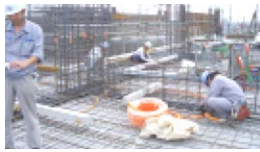
施工現場の様子
