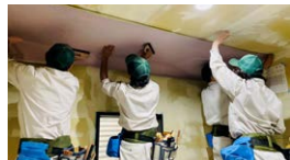
天井の壁紙張り実習
