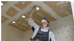
天井下地調整作業
