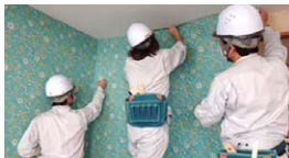
内装仕上(壁装)の施工実習
