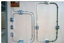
電気工事実習(全体)
