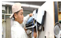
ルームエアコン取り付け作業
