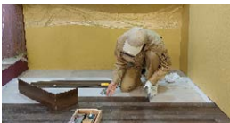
床仕上げ施工実習
