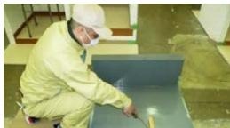
外装仕上(塗膜防水)の施工実習
