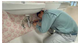
洗面器取付作業
