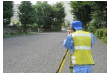
トラス測量 (角度・距離の観測)
