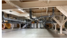
給排水衛生設備 [配管及び器具設置]
