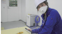
石膏ボードの加工 (建築下地作業)
