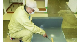
外装仕上(塗膜防水)の施工実習
