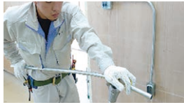
電気工事実習
