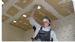
天井下地調整作業
