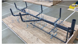
屋内給排水設備 [配管施工]
