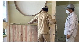
技能祭店舗設計・施工実習
