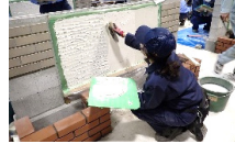
外構実習 仕上げ作業の様子
