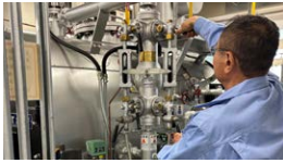
ボイラー操作
