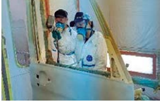
塗装作業の様子
