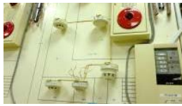
防災設備工事作業実習課題
