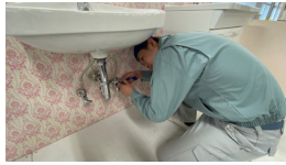
衛生機器取付け作業
