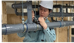
排水配管作業
