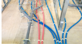
建築設備(配管)の施工実習
