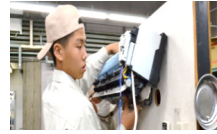
ルームエアコン取り付け作業
