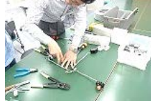
電気工事作業
