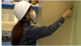
建築塗装作業
