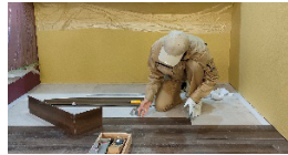
床仕上げ施工実習
