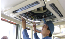
業務用エアコン メンテナンス作業
