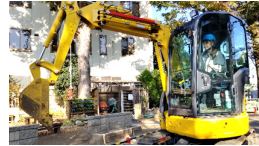
屋外配管施設 [外構 掘削作業] 特別教育小型車両系建設機械運転
