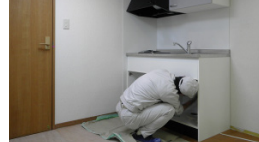
給排水衛生設備 (機械設備作業)
