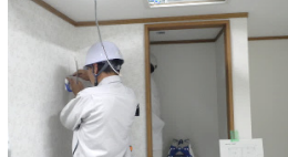
電気配線 (電気設備作業)
