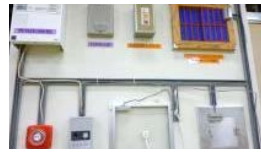
防犯設備工事作業実習課題
