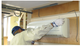
エアコン取付作業
