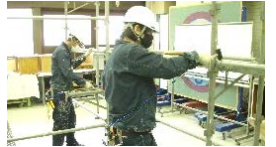
足場の組立て作業
