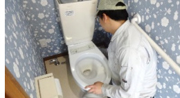
建築設備(衛生器具)の施工実習
