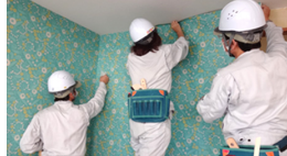
内装仕上(壁装)の施工実習
