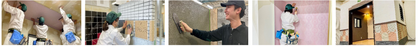
天井の壁紙張り実習
