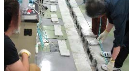
床配線の交換
