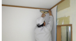
壁装作業 (建築仕上作業)
