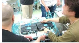
ルータの配線準備
